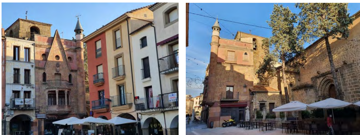
Fachadas principal y lateral diseñadas en 1936 por Francisco Mirón
