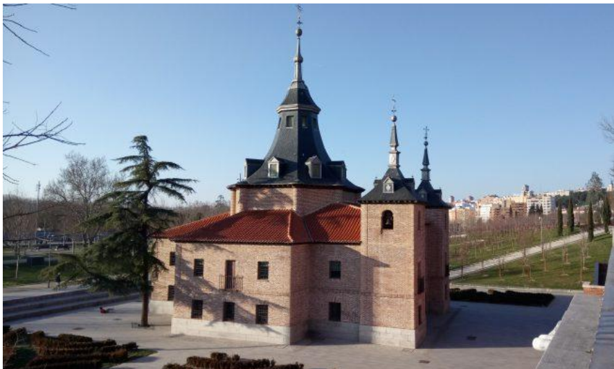
Santuario del Puerto, construida entre 1716 y 1718 por Pedro de Ribera, Madrid.
